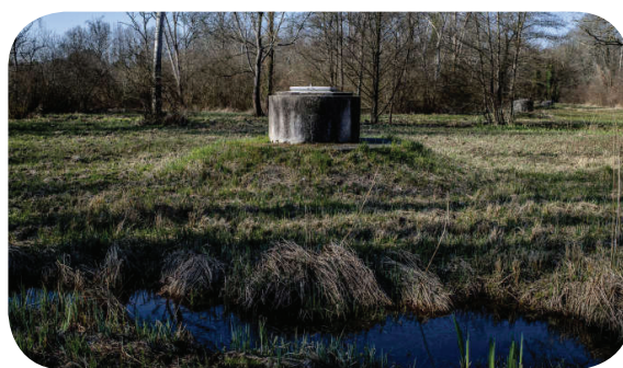
Des puits de captage d' Eau de Paris , près de la source du Villeron à Villemer, en Seine-et-Marne ©Bruno Fert pour Le Monde
