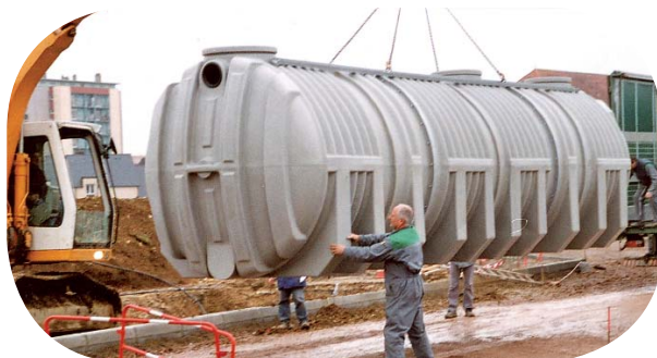
Au Centre Technique Municipal, une cuve de 32 000 litres permet de récupérer les eaux de pluie, depuis 2007
